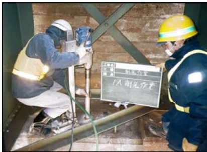
コア抜き状況
