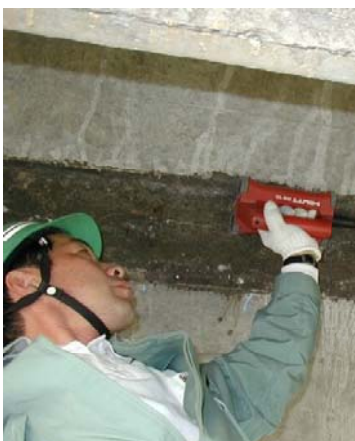
鉄筋探査試験
